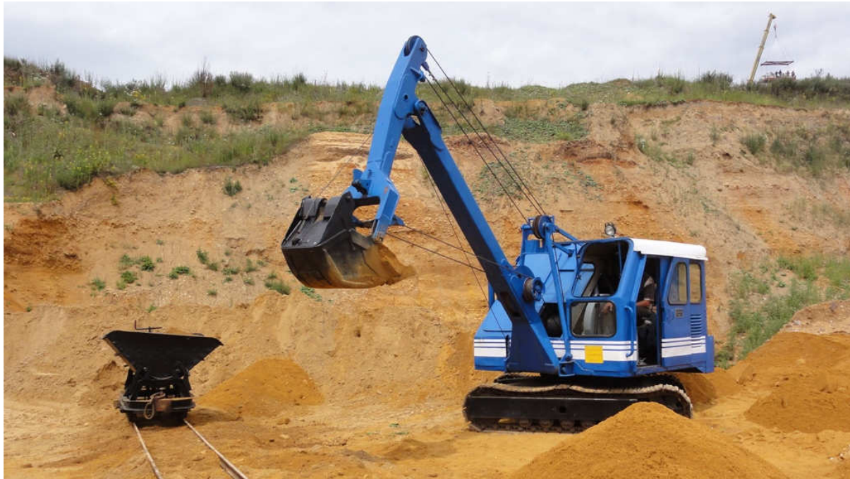
Der Weserhütte-Tieflöffelbagger beim 4. Historischen Baumaschinen- u. Kippertreffen in Weilbach. Foto: Udo Przygoda 02.07.2011
